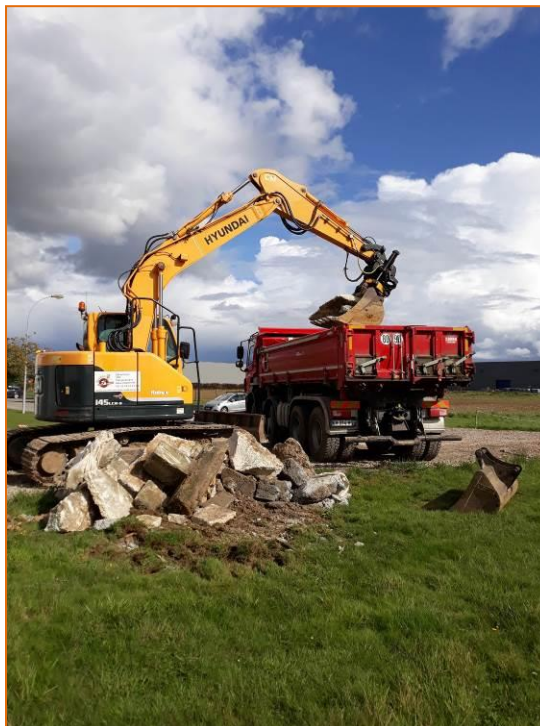
Figure 20 : Evacuation des bétons
