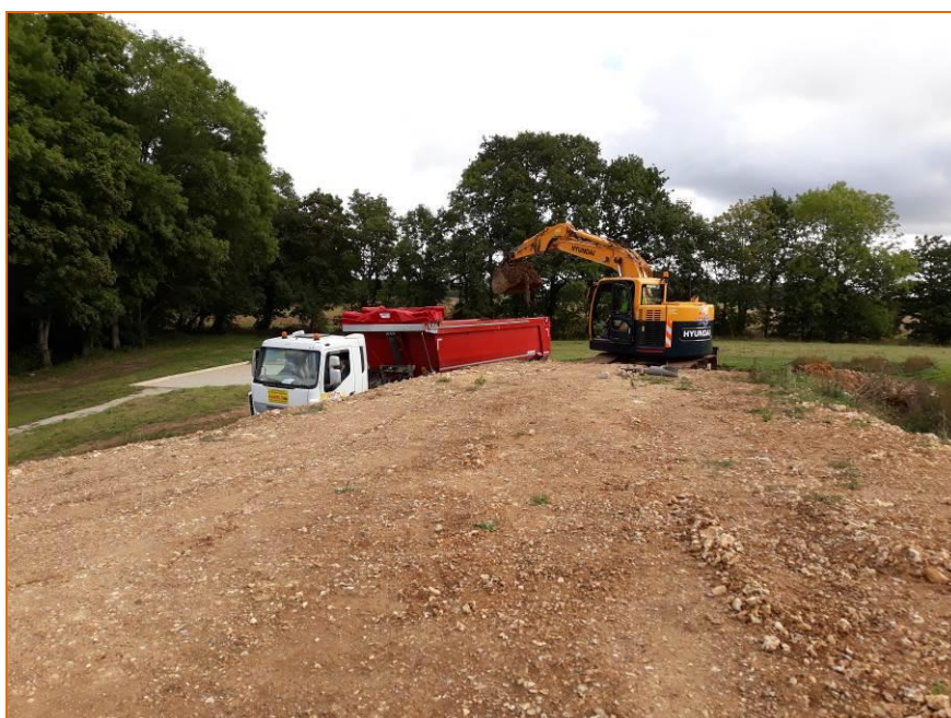
Figure 14 : Chargement des matériaux de remblaiement (site d'origine)
