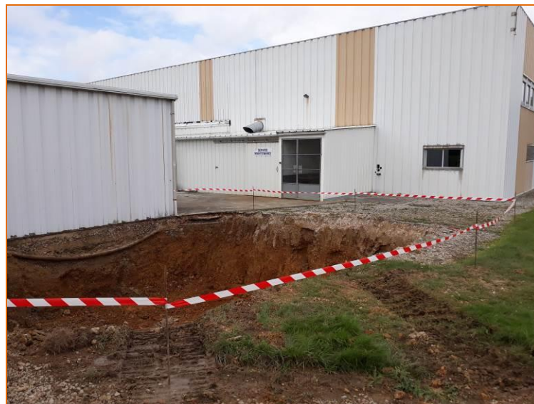
Figure 9 : Sécurisation de la fouille en attente de réception des résultats d'analyse pour remblaiement
