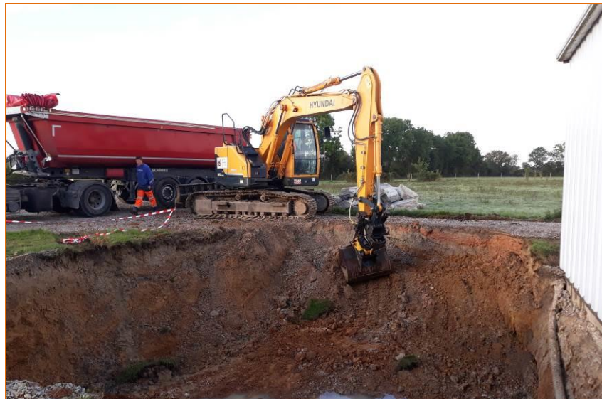
Figure 11 : Poursuite des terrassements pour évacuation en filière
