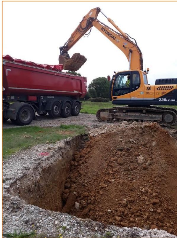
Figure 7 : Chargement en camion bâché pour évacuation en filière
