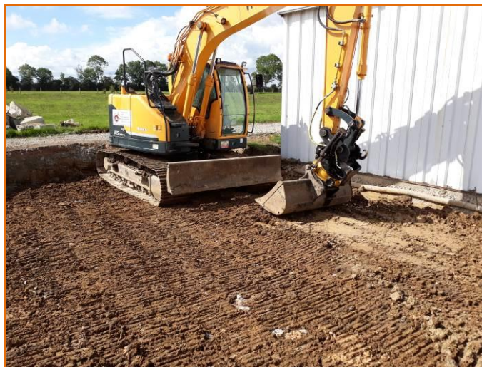
Figure 17 : Mise en œuvre et compactage à la pelle mécanique
