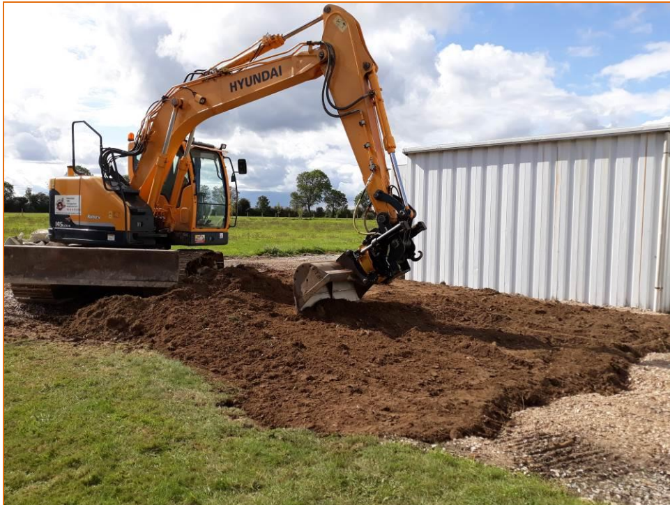
Figure 19 : Mise ne place terre végétale
