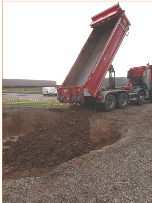
Figure 16 : Apport des matériaux de remblai dans la fouille
